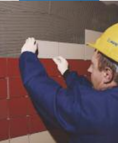
Укладка керамической плитки на стены сверху вниз
