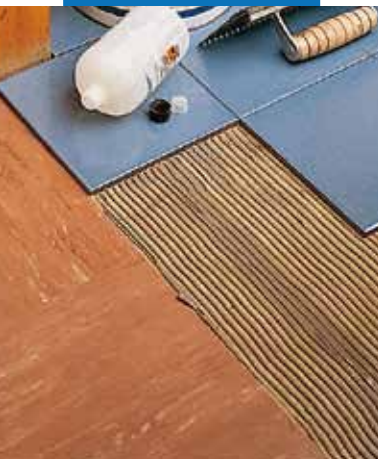
Укладка на старое ПВХ покрытие
