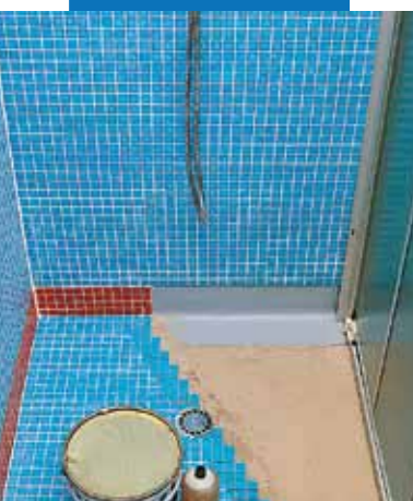
Гидроизоляция и укладка облицовки в душевой кабинке
