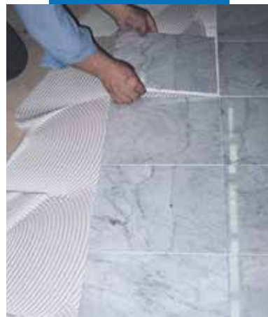
Укладка мрамора Saigara на деревянное основание, используя белый Keralastic
