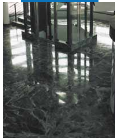
Полы, облицованные зеленым мрамором "Alpi" в холле здания Rolex (Бленн - Швейцария)
