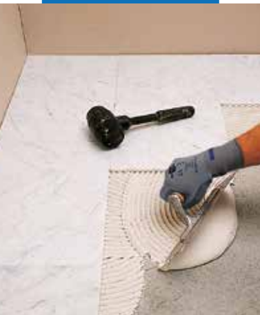
Укладка белого мрамора Carrara с помощью Keraquick S1.
