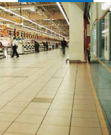
Пример облицовки с помощью Keraquick S1, супермаркет «Ашан» – Сосновец (Польша)
