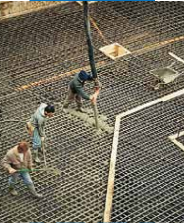
Заливка фундамента супертекучим бетоном, приготовленным с Mapefluid PZ500
