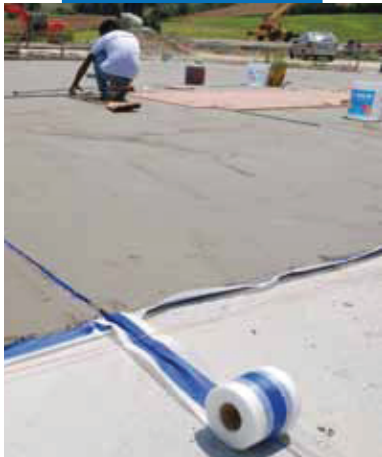
Гидроизоляция стяжек с Mapeelastic и Mapeband
