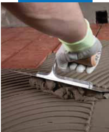
Нанесение Granirapid на террасу с гидроизоляцией Mapelast
