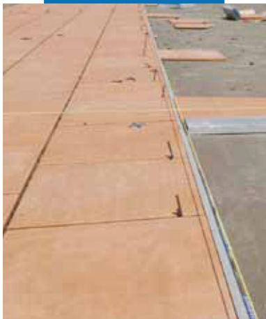
Укладка керамической плитки на Kerabond + Isolastic
