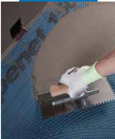
Нанесение Mapelast на Mapenet 150
