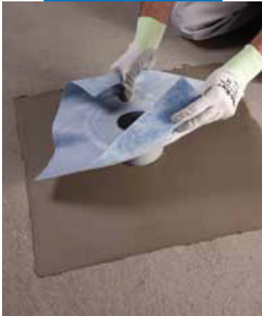
Укладка Drain Vertical на Mapelast
