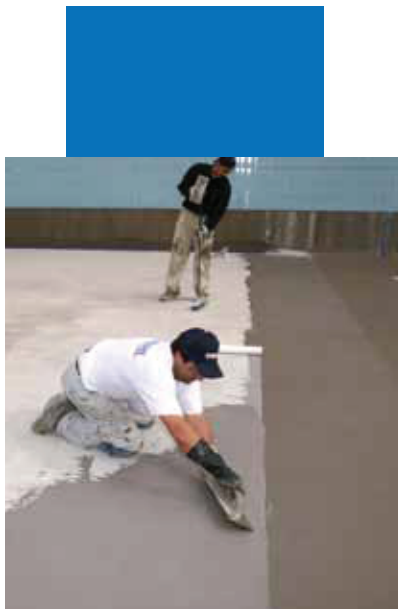
Гидроизоляция плавательного бассейна с помощью Mapelastic
